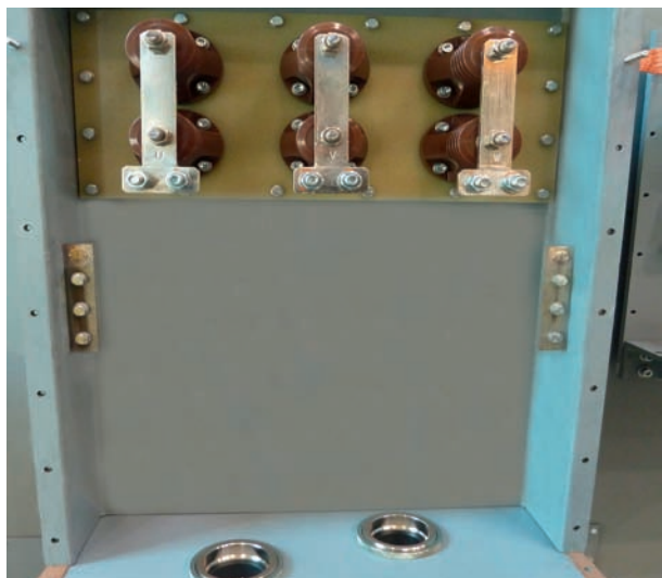
Пример соединительных коробок статора
