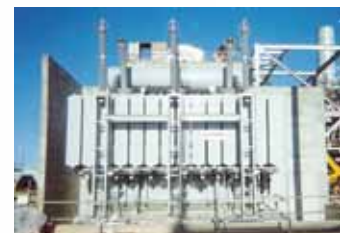
Генераторный повышающий трансформатор 235кВ/205МВА на Sempra Energy в США
