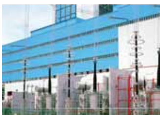
Генераторный повышающий трансформатор 765кВ/204МВА Теплоэлектростанция Дангджин, Корея.
