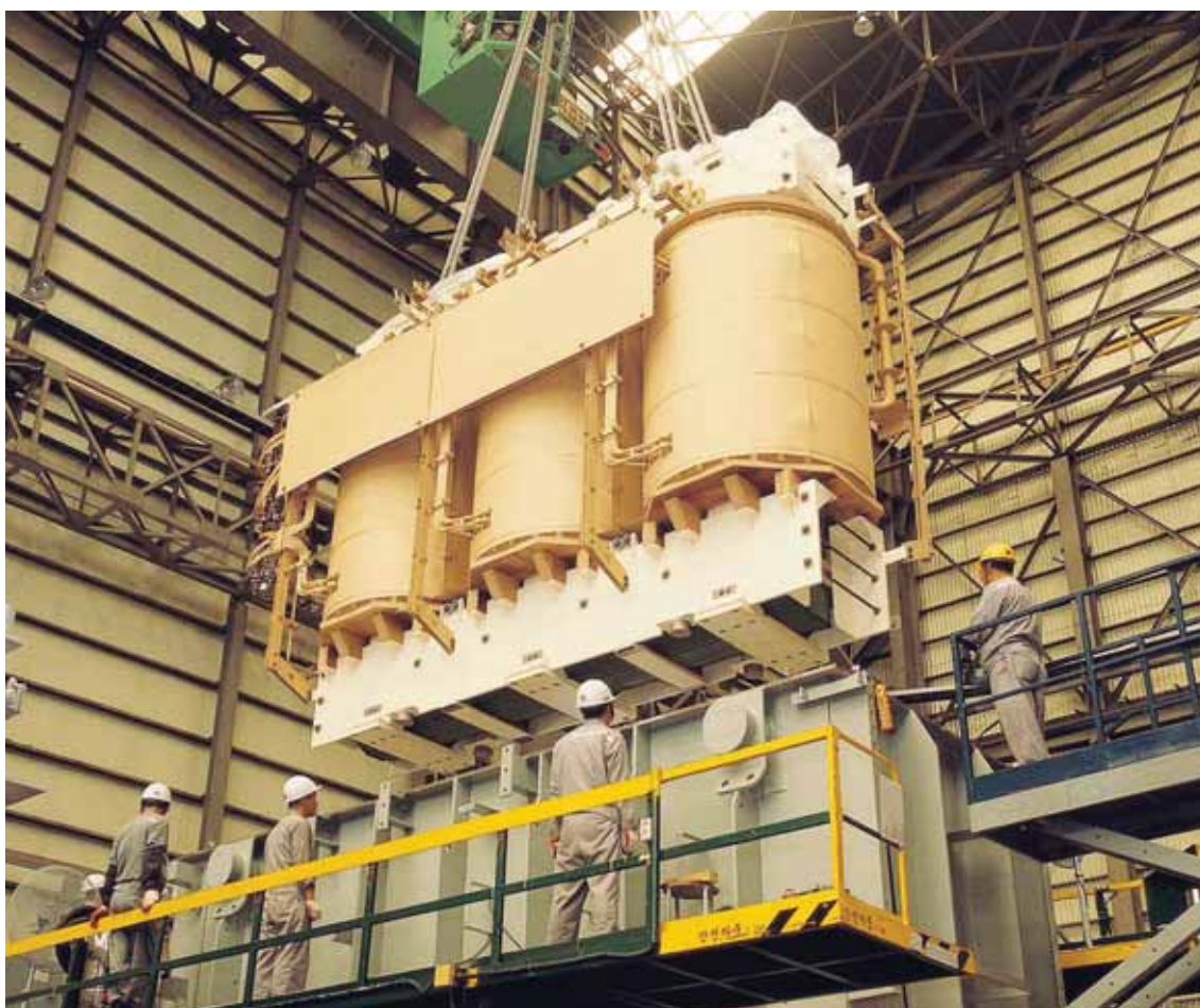
Трансформатор в процессе сборки
