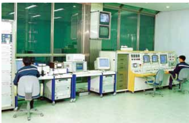
Пост управления высоковольтной лабораторией
