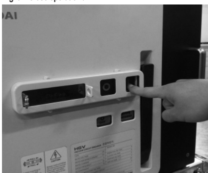
Fig. 3-4 Close operation / Рис. 3-4 Включение
