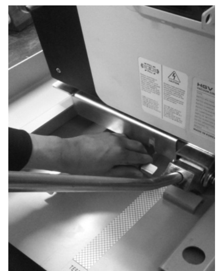
Рис. 4-7 Установка выключателя, тип E/F
