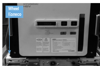
Рис.4-8 Установка выключателя, тип G/M (1)
