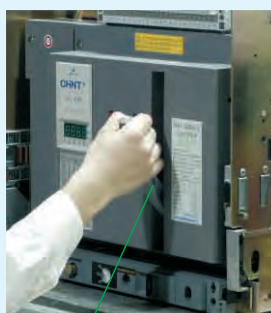
Рукоятку механизма взвода 6 раз переместить вниз до упора ( до защёлкивания )
